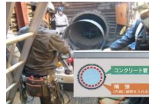
例：管路の耐震補強
