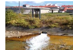
坑廃水処理等の実施
